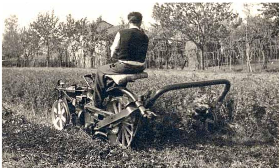
Il **primo prototipo in lavoro di falciatura**: da notare le ruote in ferro e l'arco porta-lama squadrato
